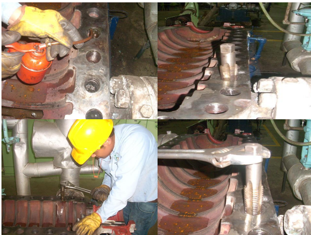
Foto 39. Limpieza con machuelo para definir roscado de la carcasa – Bomba de alimentar caldera 1A.
