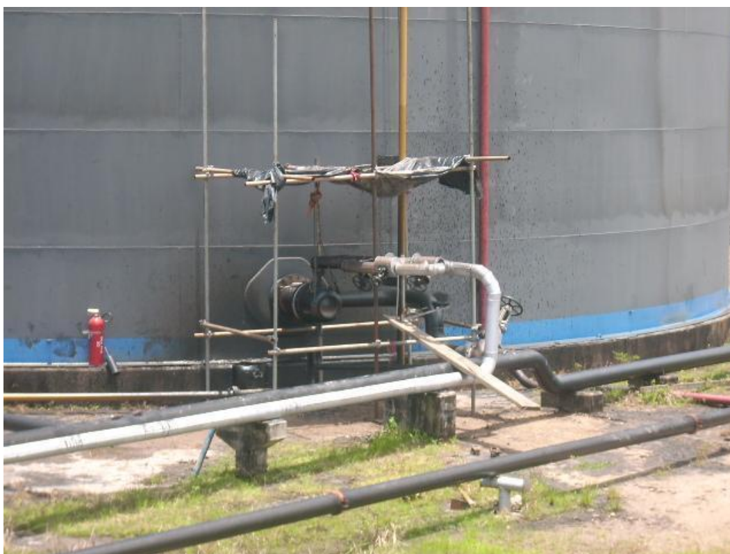
Foto 86. Zona de trabajo, fuga de combustible cabeza- Tanque unidad 3.
