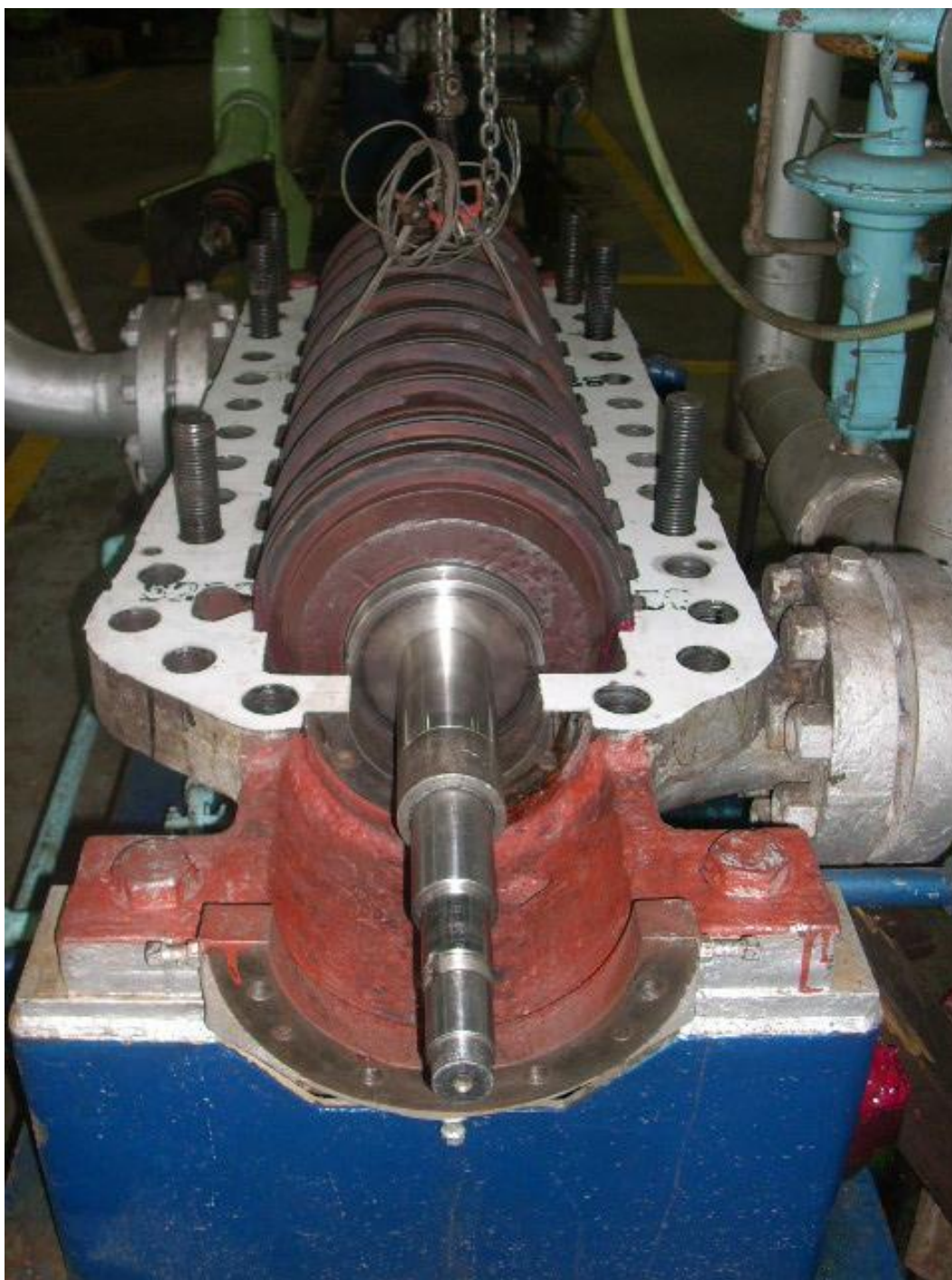
Foto 59. Eje instalado – Bomba de alimentar caldera 1A.
