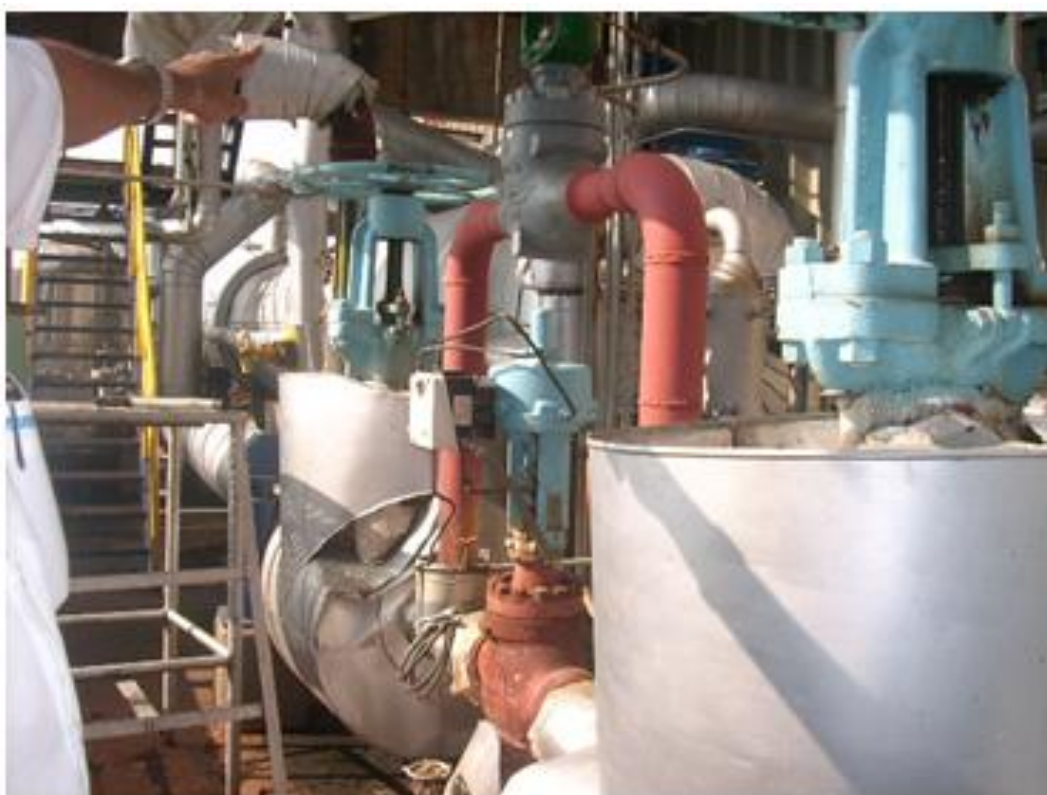
Foto 9. Válvulas entrada de agua caldera 3.
