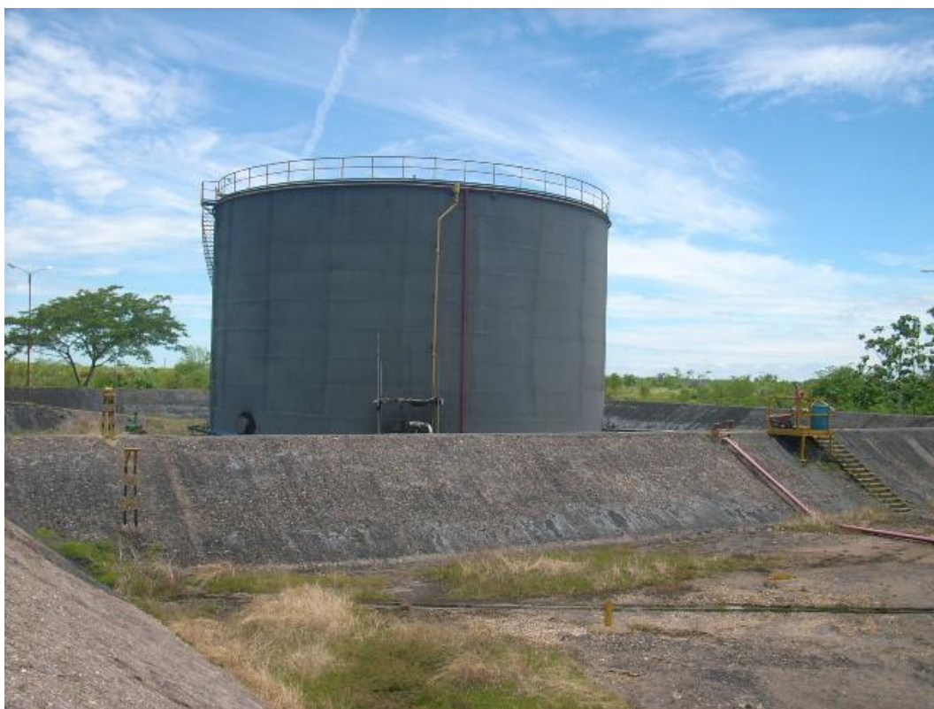
Foto 87. Tanque de almacenamiento fuel-oil unidad 3, capacidad 5000 m 3 .
