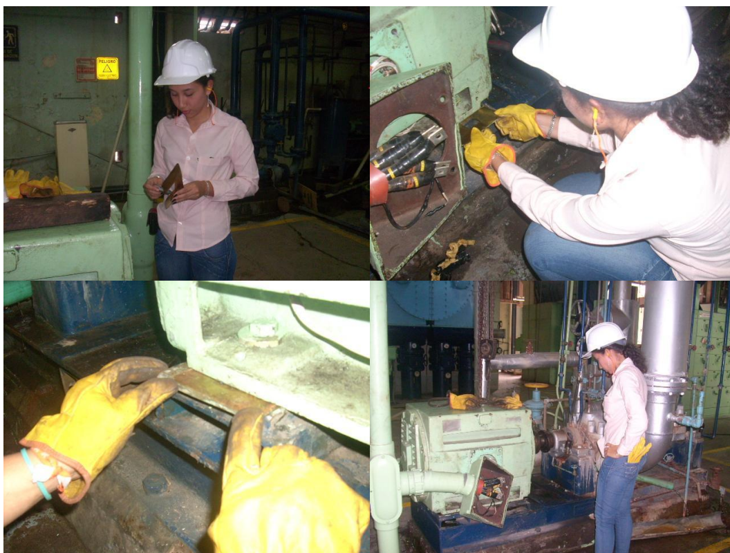
Foto 71. Calzando shims a las patas del motor (Alineamiento paralelo angular) – Motor bomba de alimentar caldera 1B.
