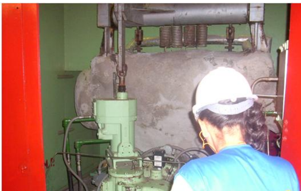
Foto 2. Válvulas de regulación entrada de vapor – Turbina 1.
