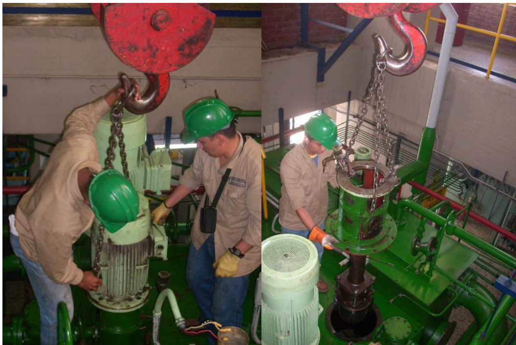
Foto 79. Desmontaje motor y cuerpo de la bomba – Bomba de aceite de baja presión.
