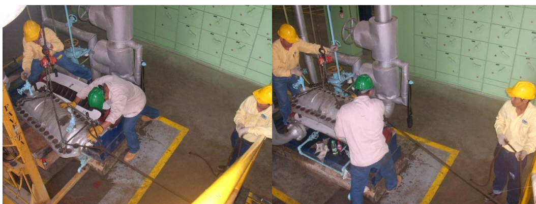
Foto 52. Instalación tapa superior de la carcasa por 24 horas para el pegado del empaque de asbesto – Bomba de alimentar caldera 1A.
