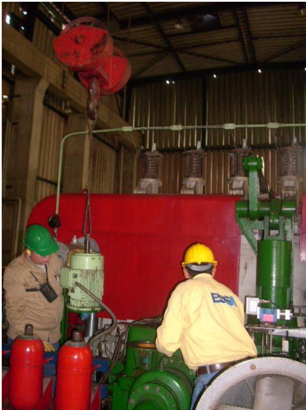
Foto 90. Retirar motor de la base – Turbina 3.
