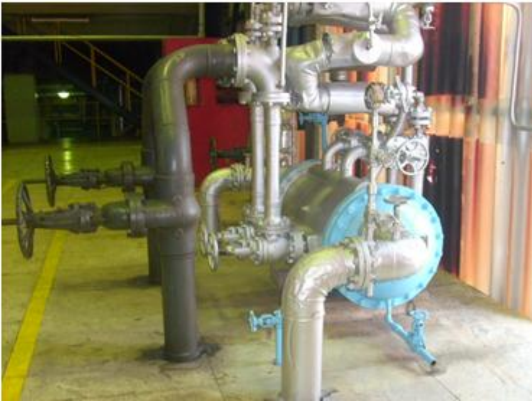
Foto 3. Eyector normal – Vacío al condensador.
