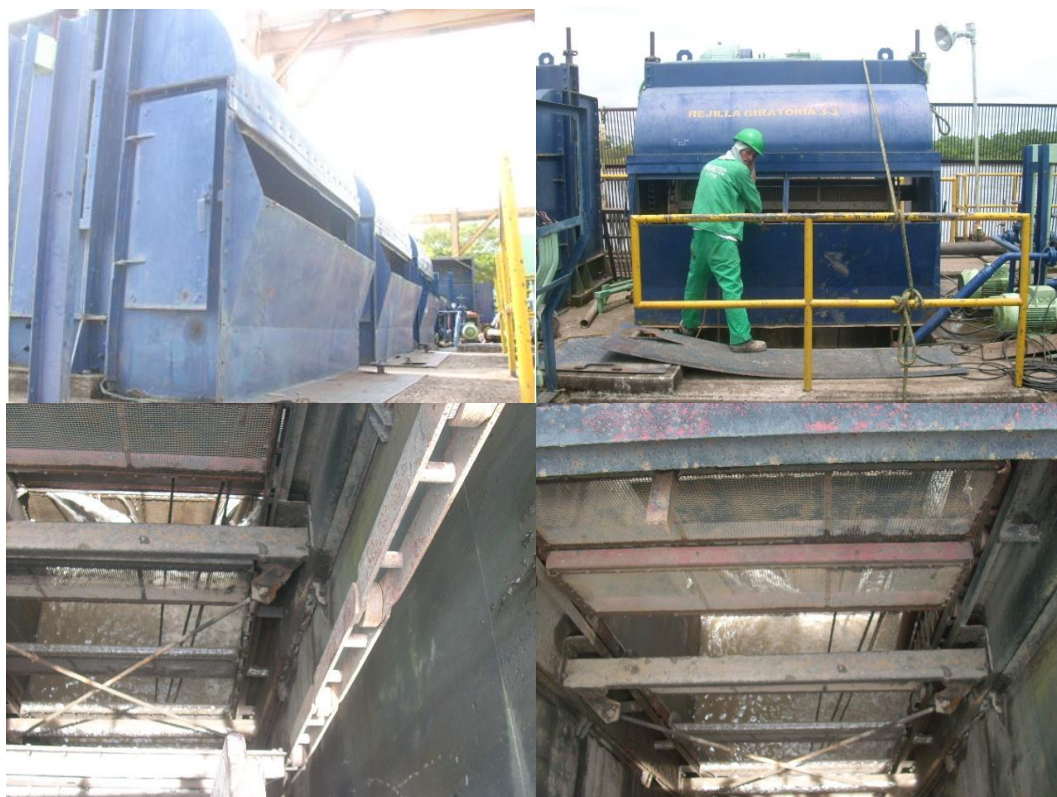
Foto 20. Rejillas giratorias (filtros) – Bocatoma.
