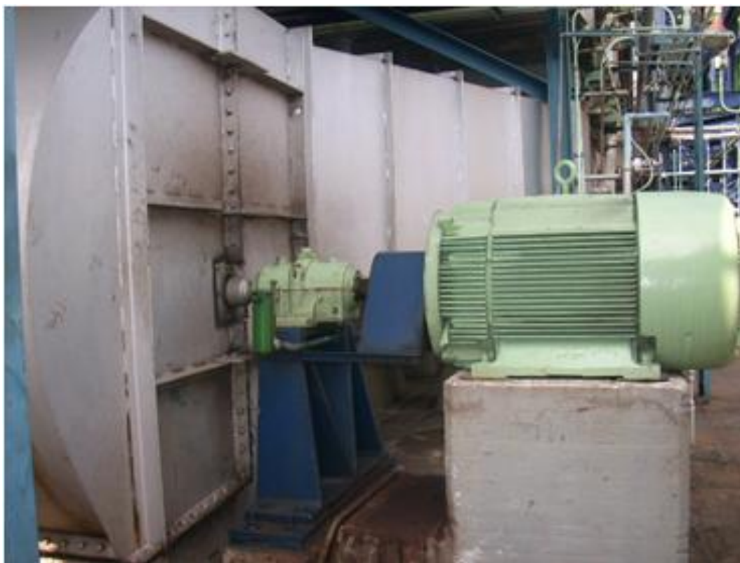
Foto 14. Motor del ventilador tiro forzado – Caldera unidad 1.
