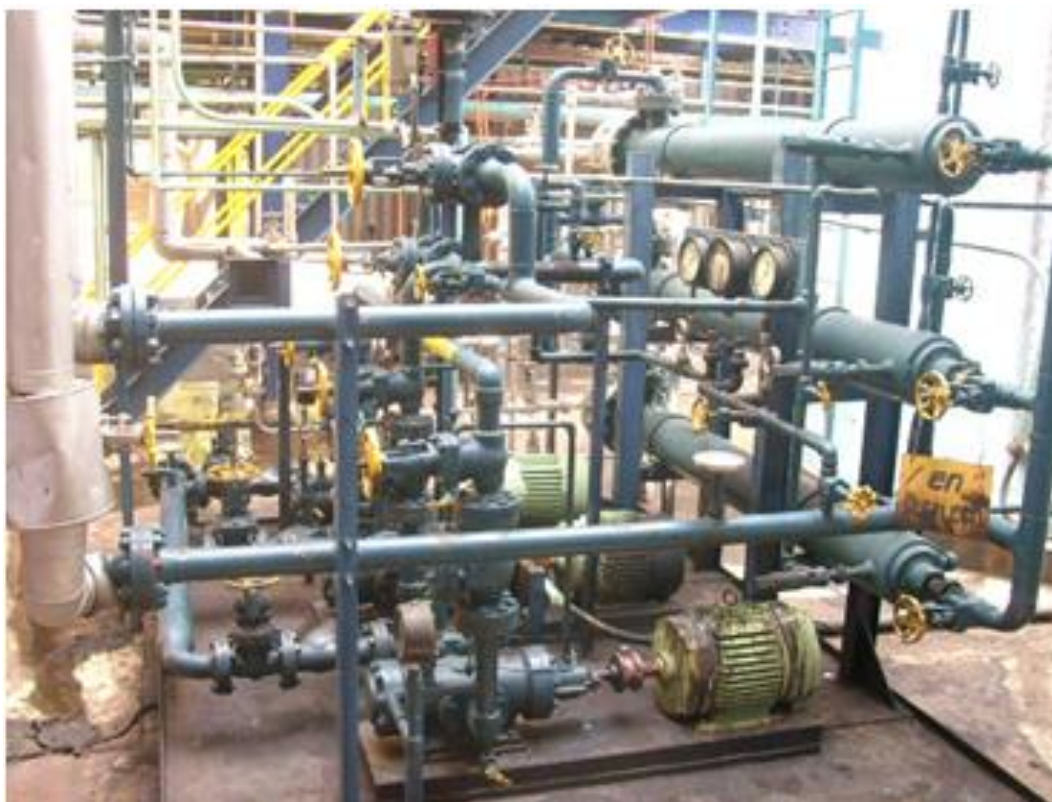
Foto 13. Estacionaria de fuel-oil a calderas 1 y 2.
