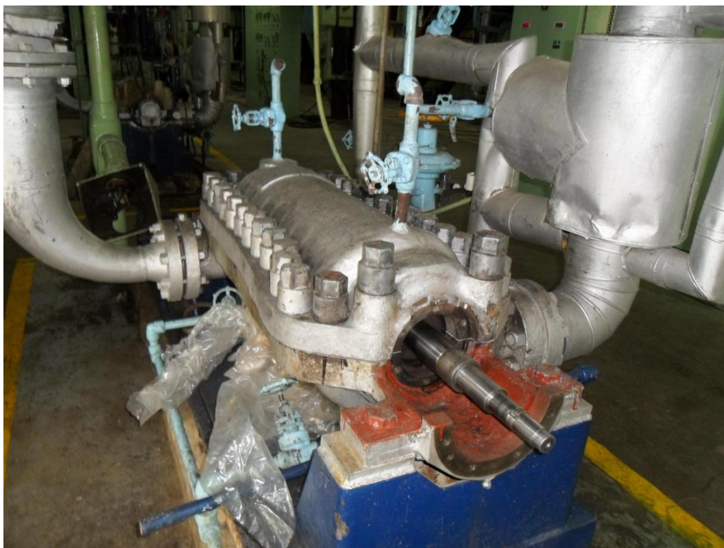
Foto 63. Cuerpo de la bomba instalado – Bomba de alimentar caldera 1A.
