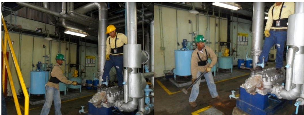
Foto 62. Apriete de las tuercas con porra – Bomba de alimentar caldera 1A.
