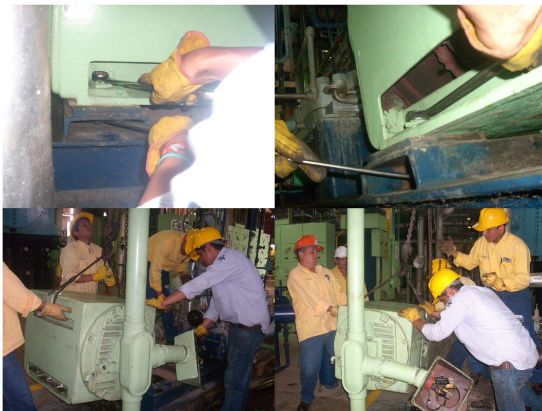
Foto 70. Montaje motor bomba de alimentar caldera 1B.
