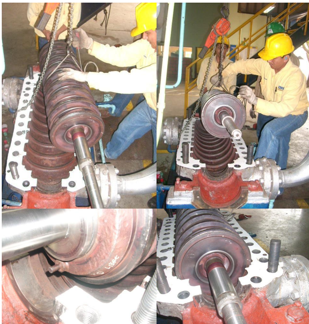
Foto 55. Instalación de eje con piezas móviles y estáticas (sistema anitigiro) para ajuste axial de los difusores con respecto a la carcasa– Bomba de alimentar caldera 1A.
