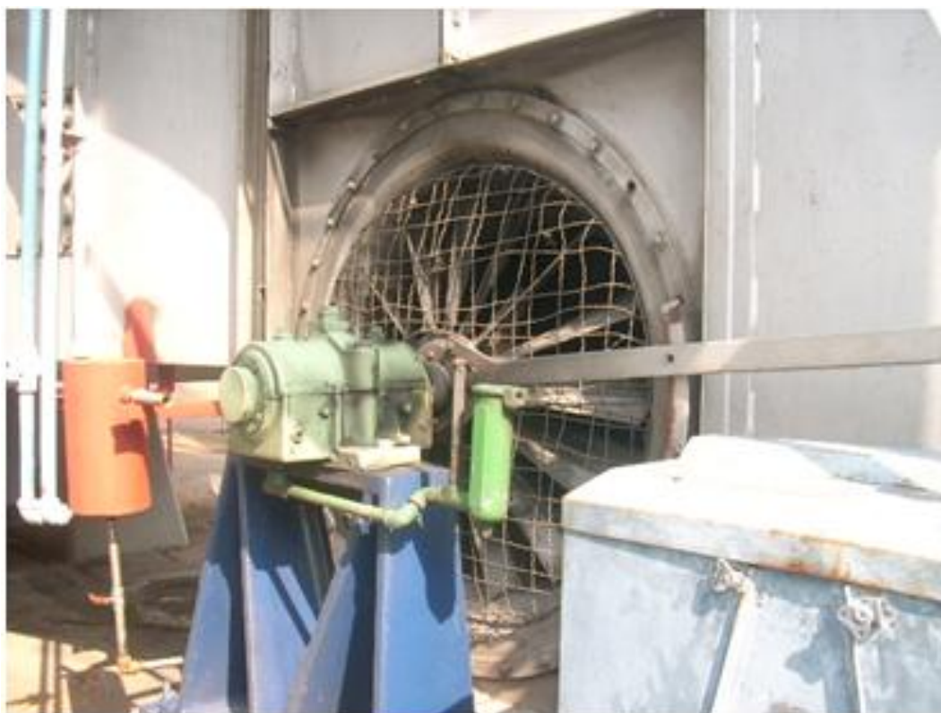
Foto 15. Ventilador tiro forzado – Caldera 1.
