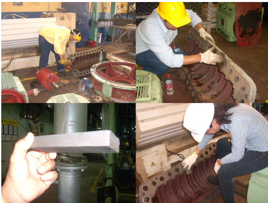
Foto 40. Limpieza con la grata y pulimento con piedra superficie tapa superior del cuerpo de la bomba – Bomba de alimentar caldera 1A.
