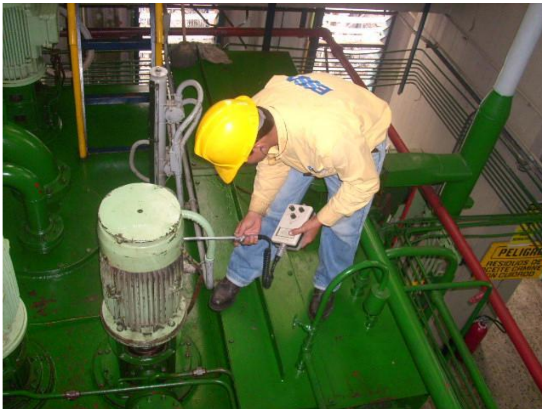
Foto 85. Bomba de aceite en funcionamiento, prueba de vibración – Bomba de aceite de baja presión.
