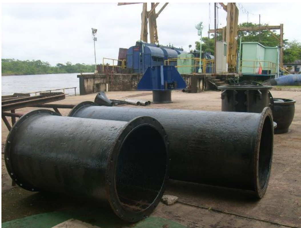
Foto 64. Ductos intermedios – Bomba de circulación 3-2.
