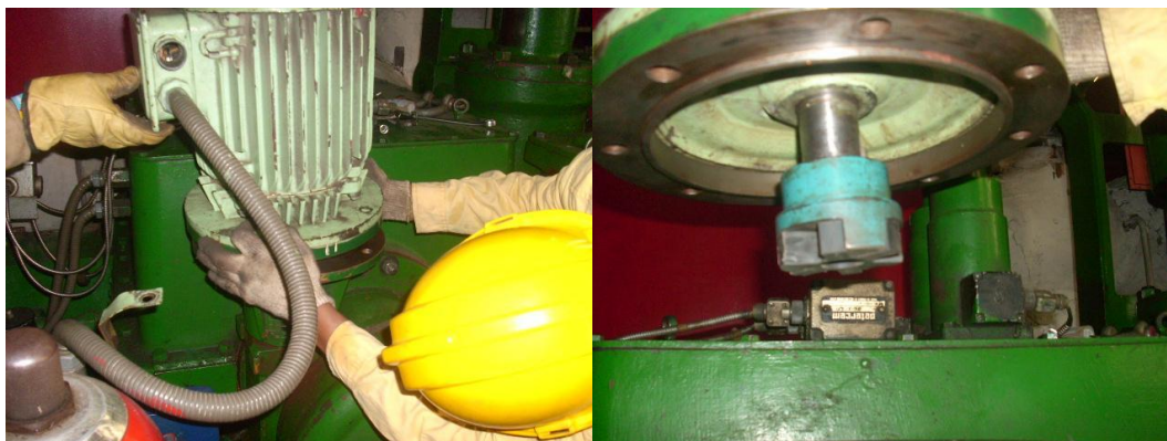
Foto 92. Instalación del motor – Zona de trabajo turbina unidad 3.
