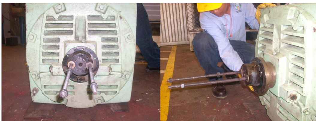
Foto 34. Acople instalado – Motor bomba 1A.
