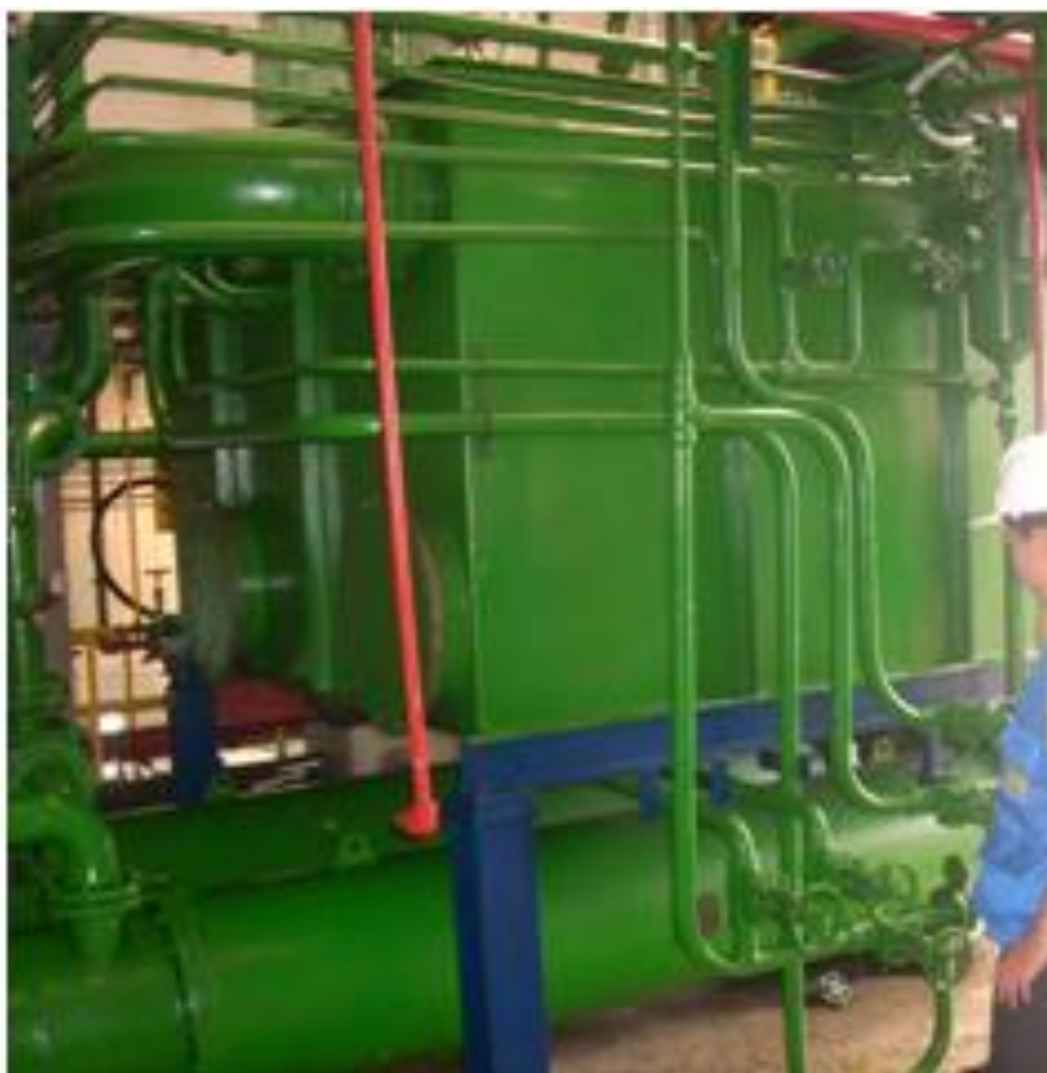
Foto 22. Consola e intercambiador de aceite unidad 3.
