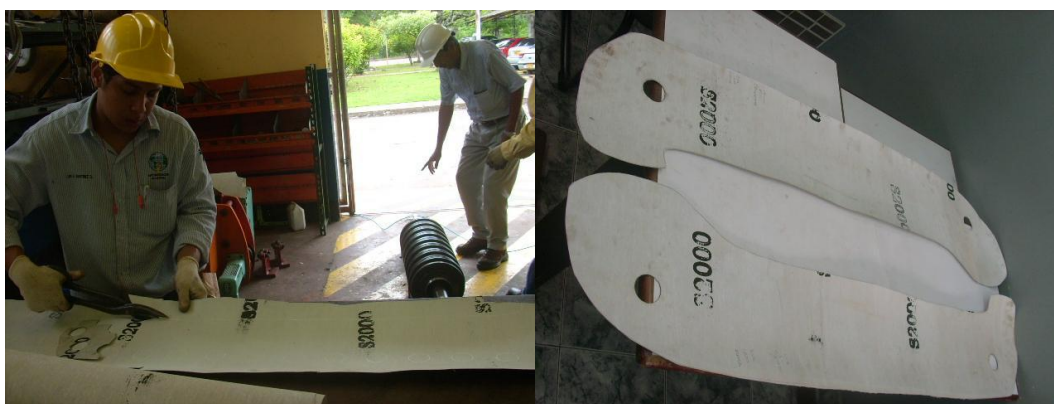
Foto 49. Empaque de asbesto; superficie de contacto entre las tapas de la bomba – Bomba de alimentar caldera 1A.
