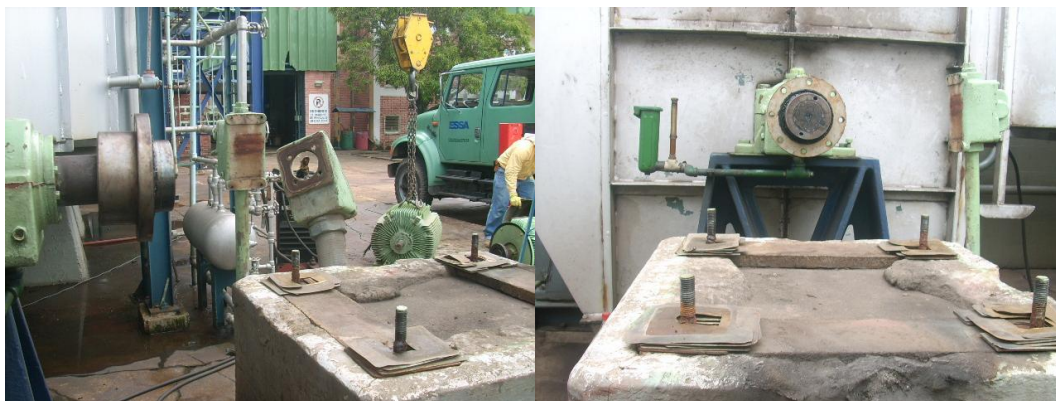
Foto 77. Base motor del ventilador tiro forzado – Zona de trabajo caldera 1.
