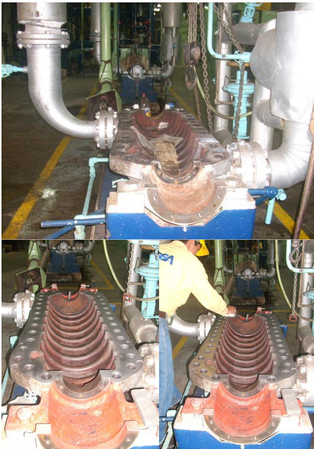
Foto 41. Limpieza y pulimento con piedra superficie tapa inferior del cuerpo de la bomba – Bomba de alimentar caldera 1A.
