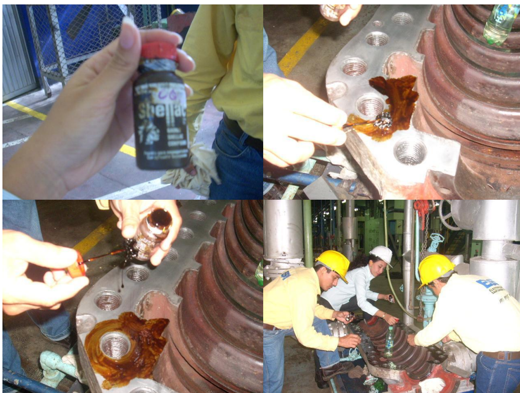
Foto 50. Pegante Shellac para el empaque de asbesto – Bomba de alimentar caldera 1A.
