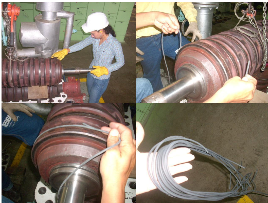
Foto 57. Medidas para los anillos de viton,sellos entre etapas – Bomba de alimentar caldera 1A.
