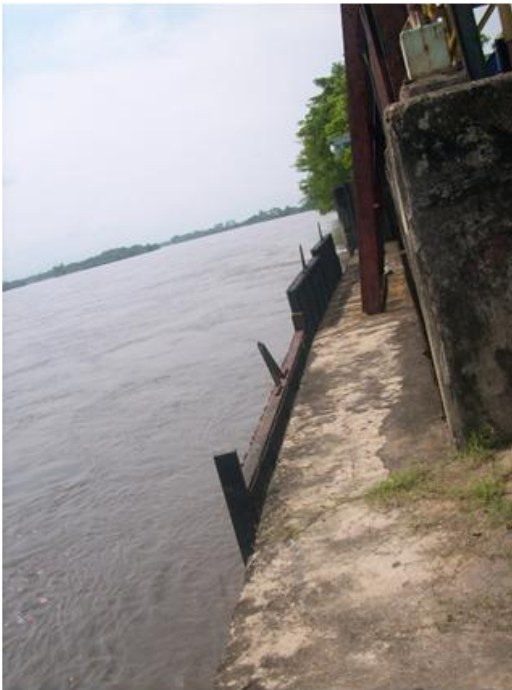
Foto 21. Rejas primarias (filtros) – Bocatoma.
