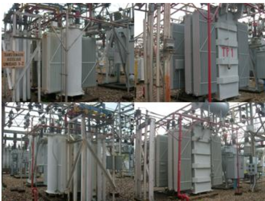
Foto 23. Transformadores – Subestación.
