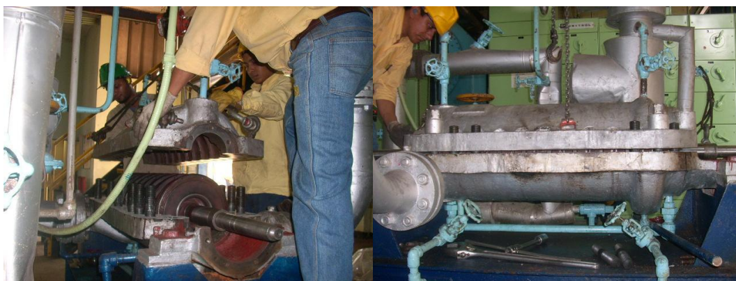
Foto 60. Instalación tapa superior de la carcasa de la bomba – Bomba de alimentar caldera 1A.
