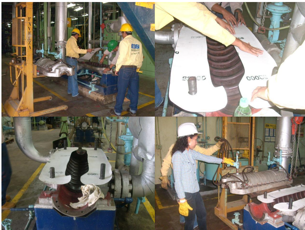
Foto 51. Empaque de asbesto instalado con 4 espárragos guía para la tapa superior – Bomba de alimentar caldera 1A.
